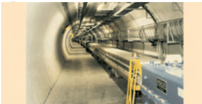
Interior del túnel del acelerador LEP. Los haces de partículas se mueven en un tubo de vacío situado en el interior de la estructura con sección rectangular (imanes) que corre a lo largo del túnel. El tamaño de éste es aparente en que apenas se vislumbra su curvatura. (CERN photo)
